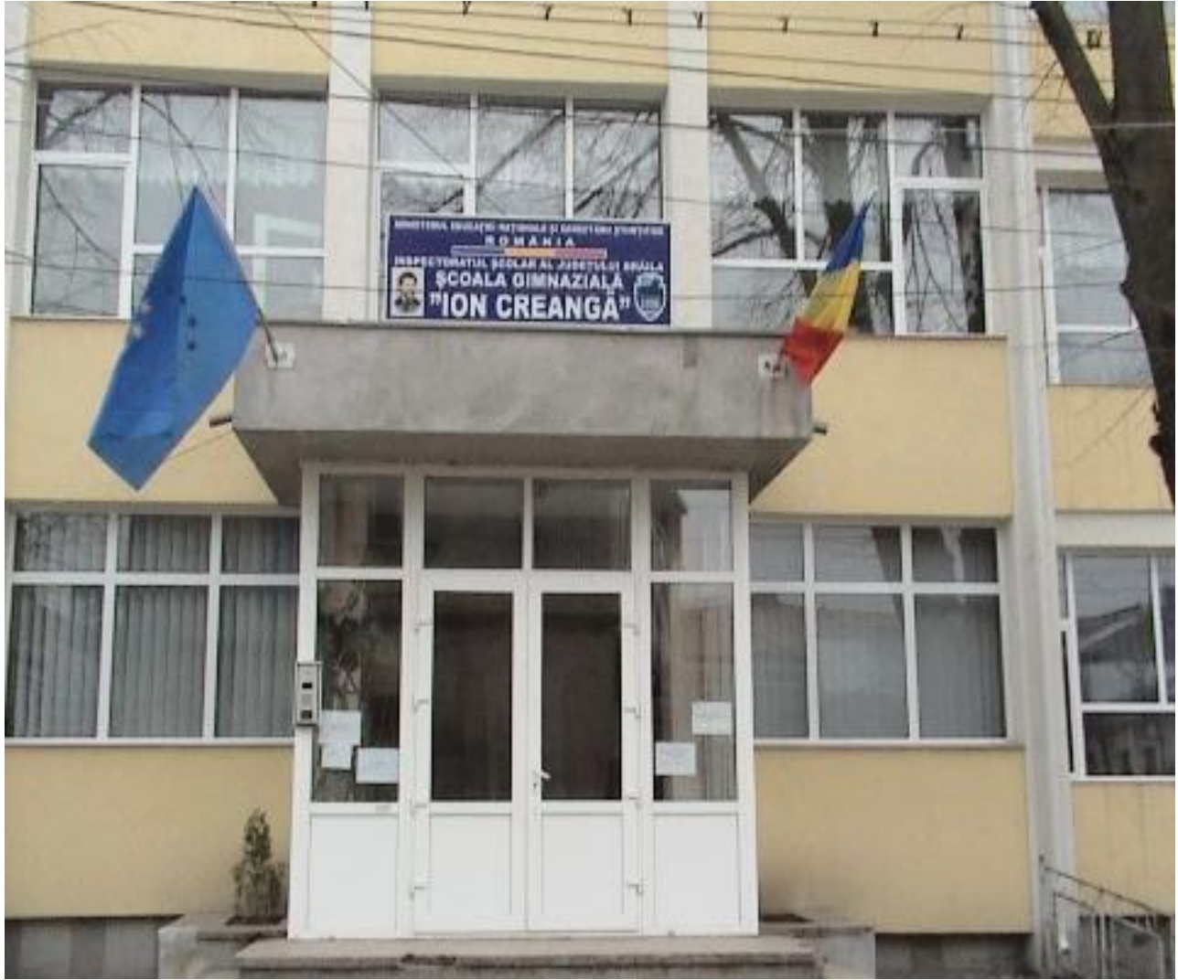
STRADA ȘCOLILOR, NR.15, BRĂILA
